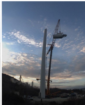
Figure 2- Démantèlement de l'éolienne
