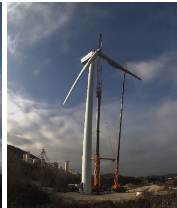
Figure 2- Démantèlement de l'éolienne
